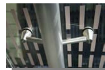
Understøtningsbeslag for glas.
